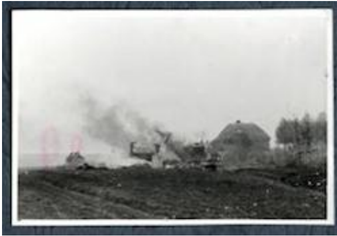
Illustration 2. Bâtiments soviétiques détruits en 1942-1943
